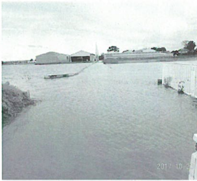
台風21号で冠水した田んぼと道路
