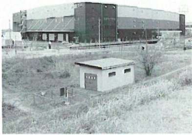
三島地区の物流施設
